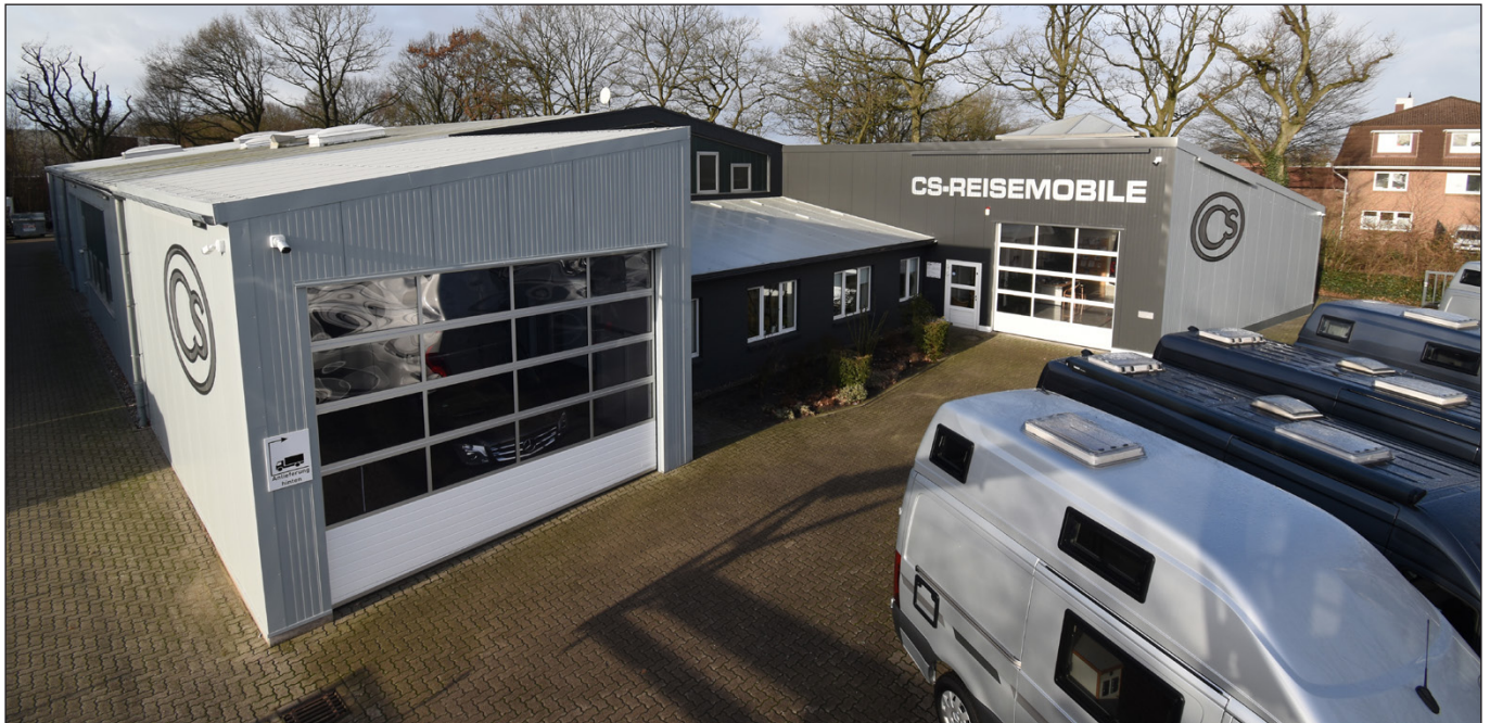
Neue Fassade für die Produktionshalle.
